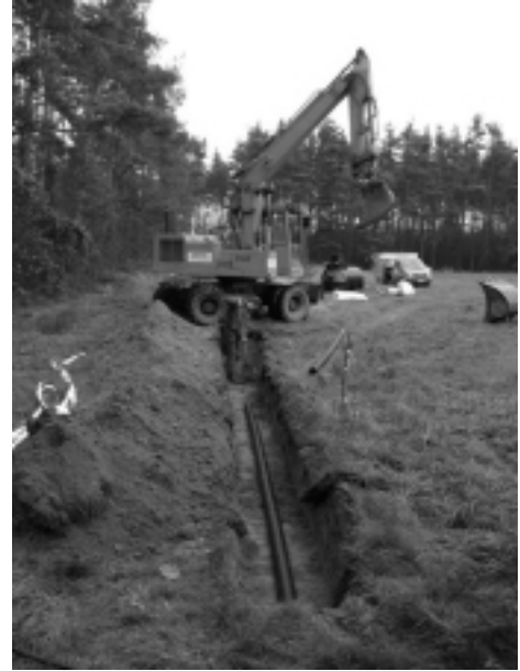
Bild 5.2.12.: Bau des Leitungsgrabens
