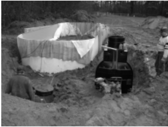
Bild 5.2.15.: Einbau des Messschachtes
