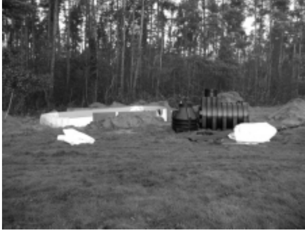
Bild 5.2.11.: Lysimeters (Bauphase), Gefälle nach links
