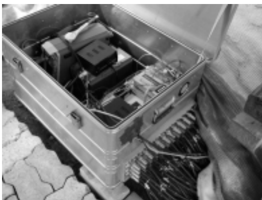
Bild 5.3.3.: Messbox mit Anschluss der Sensoren
