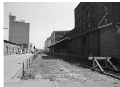
Abbildung 22: Gütergleisstreifen in der Industriestraße [Quelle: eigene Aufnahme]
