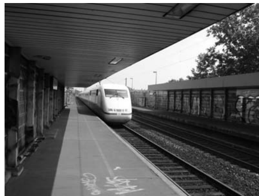
Abbildung 24: Bahnsteig des Haltepunkts Mannheim-Neckarstadt [Quelle: eigene Aufnahme]
