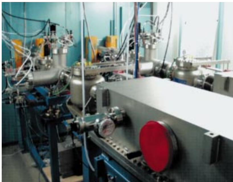
Abb. 7: Blick auf die beiden Strahlrohre LITHO 1 und LITHO 2 im Bereich der optischen Aufbauten. Im Vordergrund ist die Vakuumkammer des Spiegels von LITHO 2 zu erkennen. Im Hintergrund erkennt man die Strahlmonitore beider Strahlrohre.
