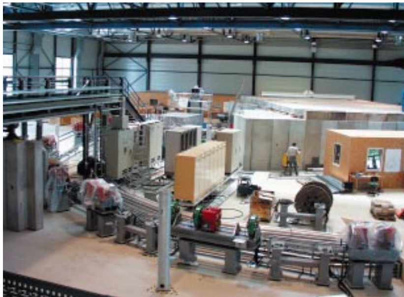
Abb. 8: Einbau der Magnete in den Speicherring.
