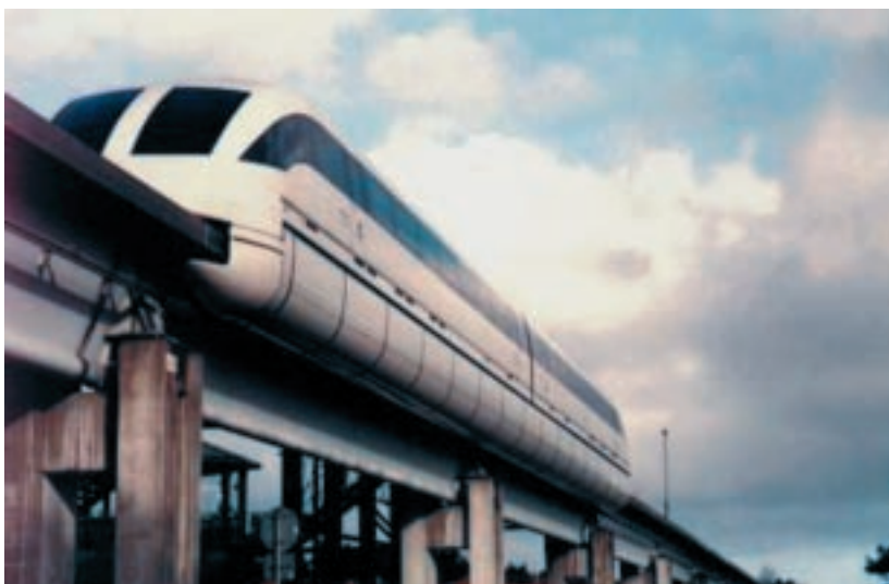
Abb. 8: Der Transrapid 07 auf einer Trasse in Hochlage.
