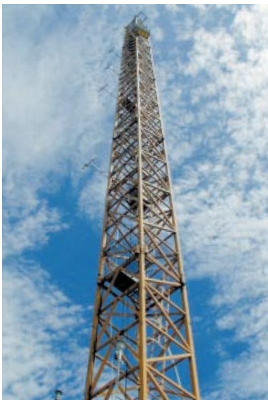
Abb. 3: Messturm mit Instrumentierung und Aufzug.
