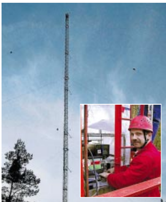
Abb. 1: Der 200 Meter hohe Messmast des Forschungszentrums. Das kleine Bild zeigt einen Mitarbeiter der Gesamthochschule Wuppertal mit einem Teil der Messgeräte, die auf dem Dach des Mast-Aufzugs installiert waren.
