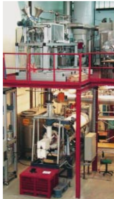
Abb. 1: Haloclean-Pydra. Die Haloclean-Pydra-Anlage im Umwelttechnikum Gebäude 691. Die Anlage erstreckt sich über zwei Etagen. Die Drehrohre sind an Brennkammer, Gaswäscher, Kühler und Probenahmeeinrichtungen gekoppelt.
