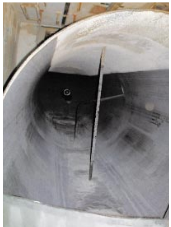
Abb. 6: Zerlegen des Ablasstankes.
