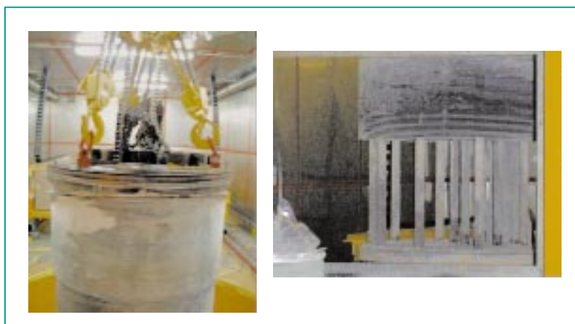
Abb. 10: Demontage des kleinen Drehdeckels.
