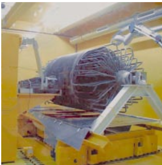
Abb. 8: Zerlegen eines ZWT-Bündels.
