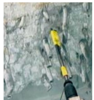
Abb. 5: Bearbeitung der Alpha-kontaminierten Betonblöcke der WAK.
