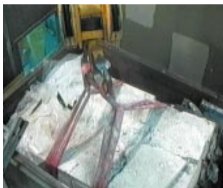
Abb. 5: Bearbeitung der Alpha-kontaminierten Betonblöcke der WAK.
