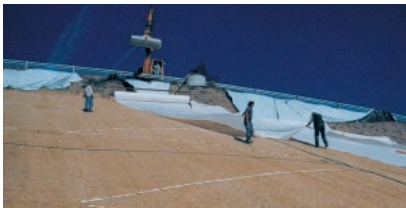
Abb. 2: Einbau von TAUPE-Feuchtesensoren auf der Mülldeponie KA-West.
