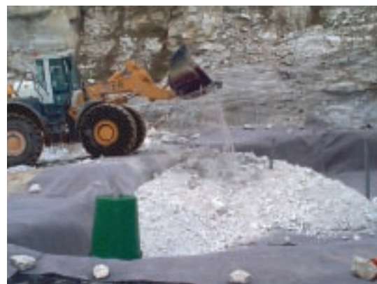
Abb. 5: Aufbau eines Großversuches in einem offengelassenen Steinbruch.
