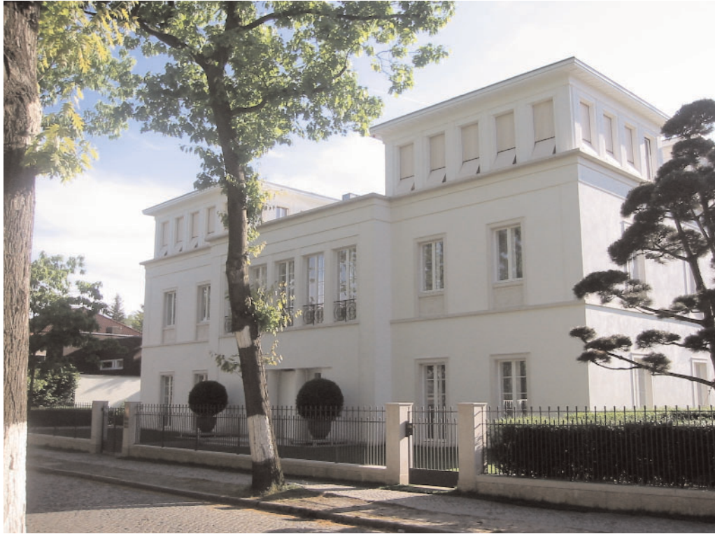
Abb. 102: Villa Gerl, Ansicht von Osten
