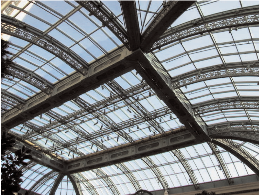
Abb. 81a: Bellagio Hotel& Casino Las Vegas, Detailaufnahme eines Glasdaches
