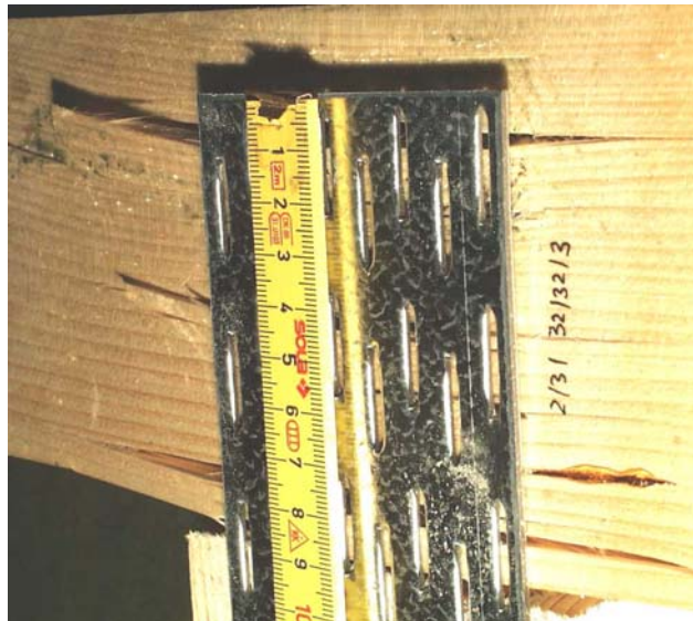
Bild 4: Querzugrisse in den Nagelspalten der Nagelplatte 2 bei der Feuchtekombination (32%, 32%) und Winkelkombination (0°, 90°)
