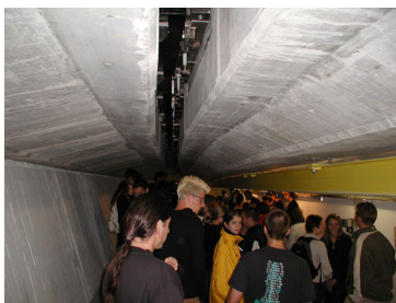
Kontrollgang zwischen Mauer und Stützbauwerk
