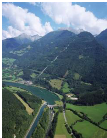
Blick auf das Kraftwerk der Malta Hauptstufe
