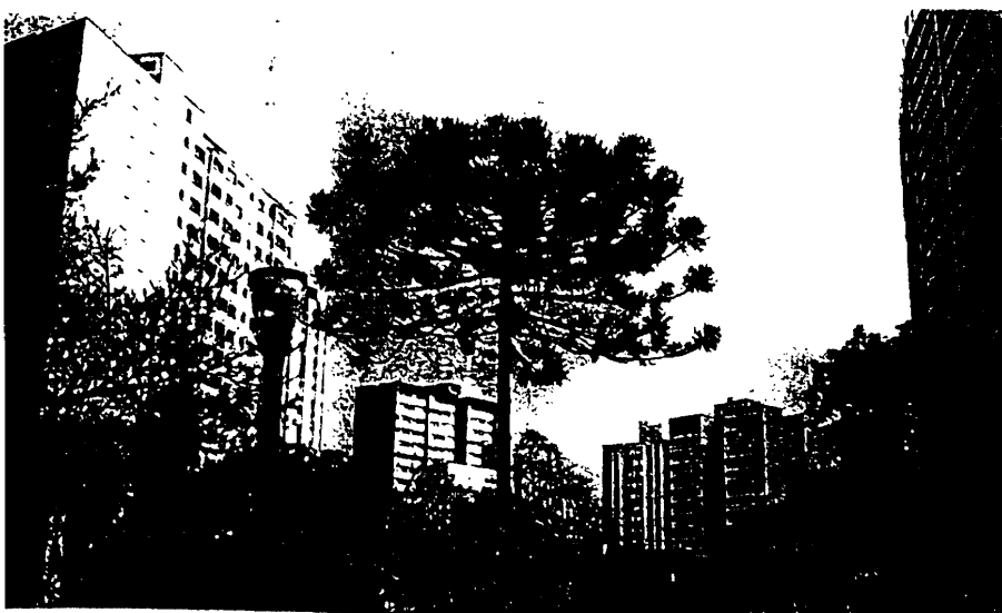
Abb. 3: Wohnhochhäuser im Stadtkern
