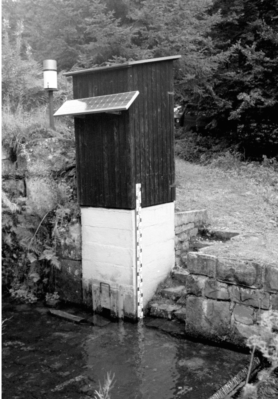
Abbildung 3-3: Der ehemalige LfU-Pegel Dürreychbachtal, im Hintergrund Niederschlagswippe der Firma ISCO
