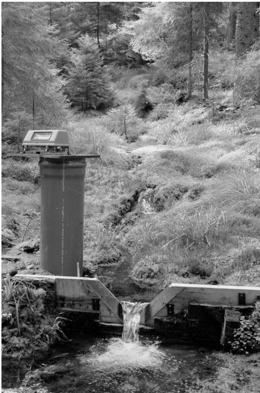
Abbildung 3-5: OTT-Schwimmpegel Stillwasserquelle (SQ)
