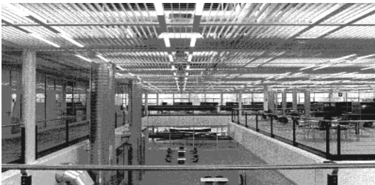
Bild 1 Der Gebäudebaukasten MIDI für bis zu viergeschossige, hochinstallierte Gebäude, wie Büro-, Schul- oder Laborgebäude. Er integriert alle technischen Systeme, so daß die Gebäude leicht an die sich ändernden Anforderungen angepaßt werden können. Abgebildet ist das Ausbildungszentrum der Schweizerischen Bundesbahn (SBB) in Murthen, das von Prof. Fritz Haller 1987 geplant wurde.
