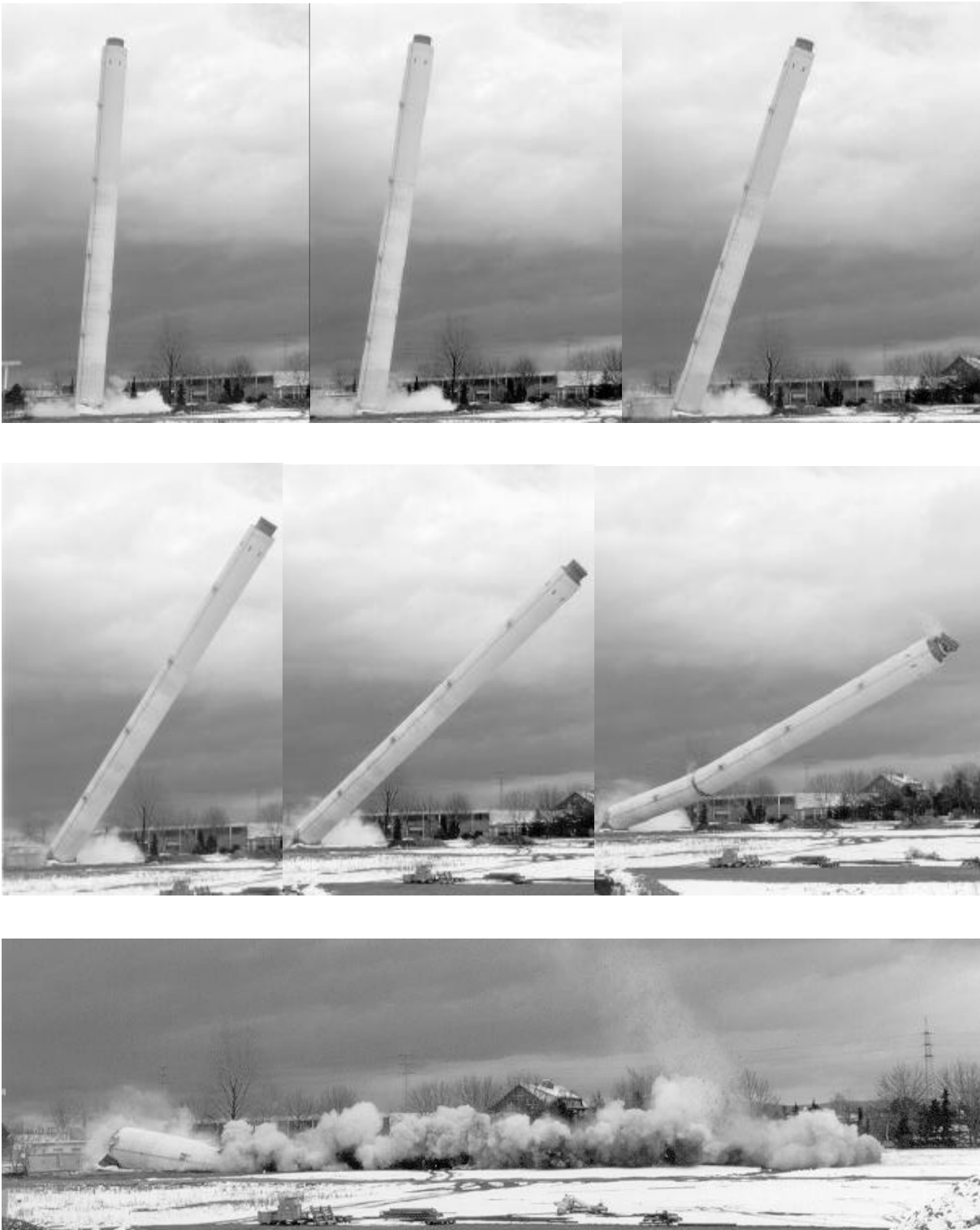
Bild 1.1: Abriß eines Schornsteines durch Sprengen
