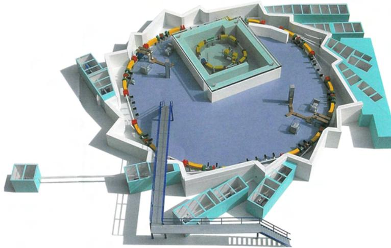
**Abbildung 9:** Charakteristisches Aussehen einer Synchrotronanlage, hier ANKA. Von den Ablenkmagneten (gelb) leiten die beamlines die Strahlung zu den Experimenten (türkis).
