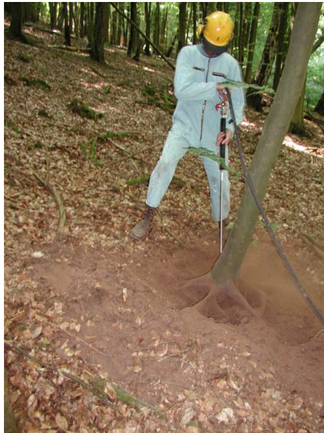
Abbildung 3.4.: Eine zügige Methode, Wurzeln schonend freizulegen, wird in diesem Bild demonstriert: Mit Hilfe von Druckluft bläst man Erde und Steine bis Faustgröße aus dem Wurzelgeflecht aus.
