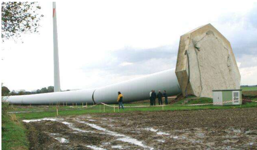
Abbildung 1.1.: Ein Beispiel einer technischer Verankerung, die der Windlast nicht gewachsen war: Ein Windgenerator mit unterdimensionierter Bodenplatte [1].
