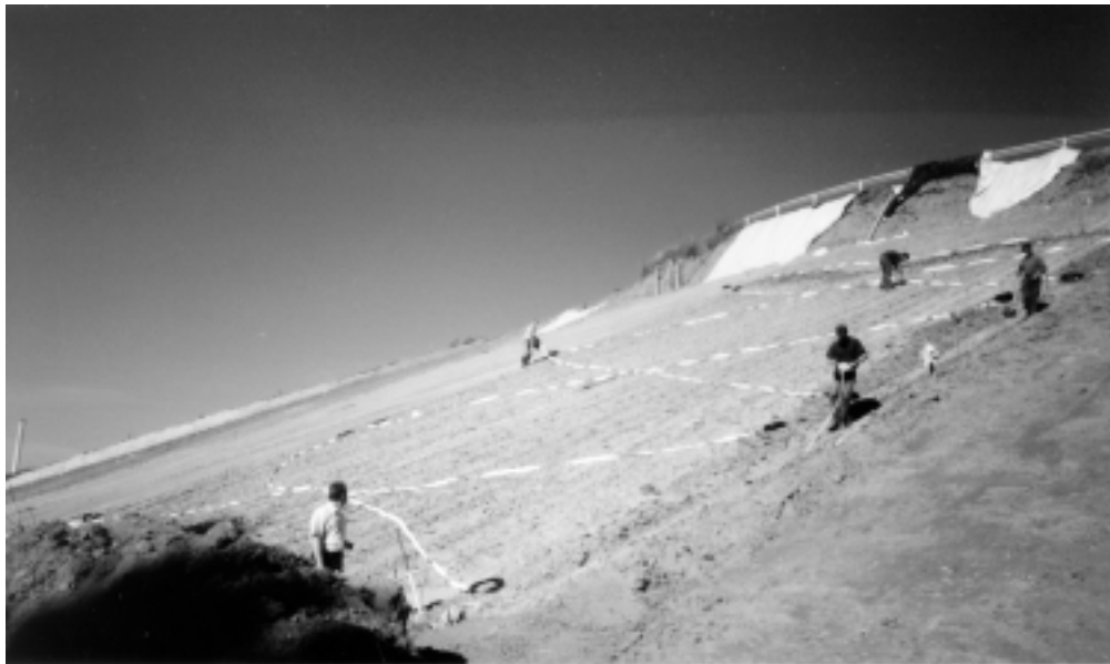
Abbildung 7.20: Verlegung des Kabelnetzwerks.
