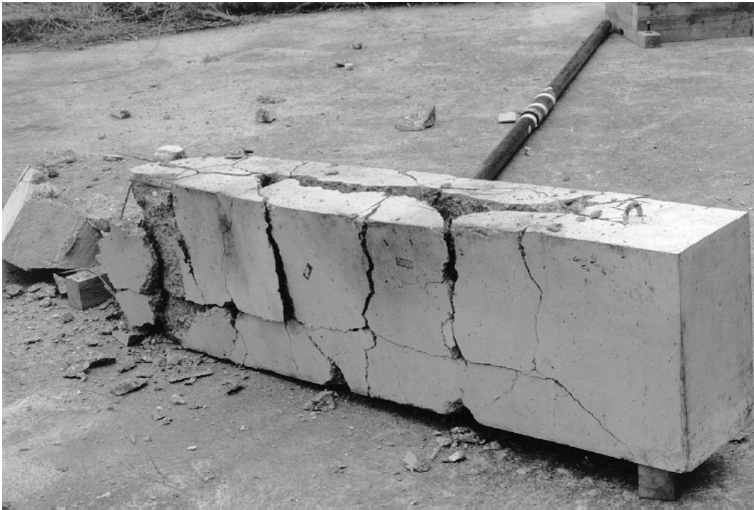
Abbildung 6-12 Sprengergebnis Balken VK3, Trennrisse durch annähernd die gesamten Bohrlochebenen (vertikal und horizontal)
