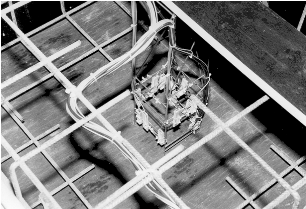
Abbildung C 19 Positionsgitter von Platte 4 (baugleich Platte 5) nach Einbau in die Schalung
