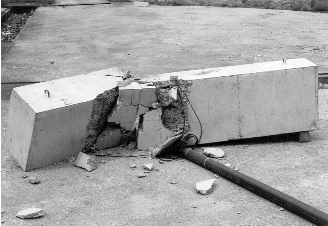
Abbildung I 15 Sprengergebnis Balken VK2, nach der Detonation einer Bohrlochladung
