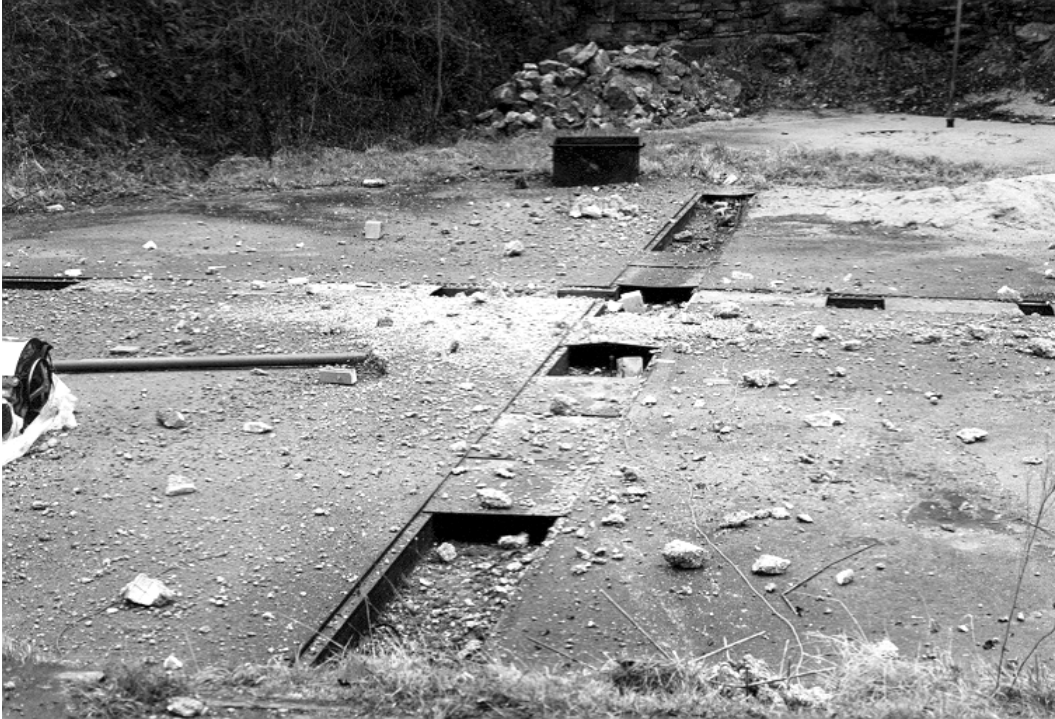
Abbildung C 7 Sprengergebnis Platte 2, totale Zerstörung
