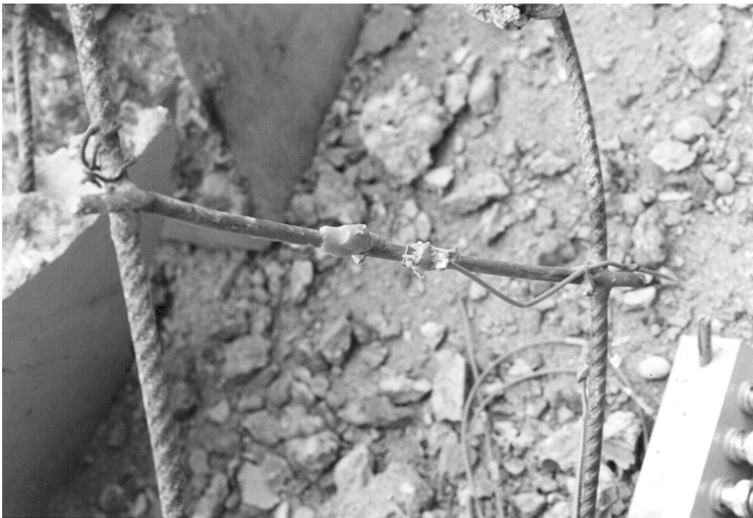
Abbildung I 30 Sprengergebnis Balken VK4, freigesprengte Bewehrung mit den Überresten eines Kohle-Masse-Aufnehmers
