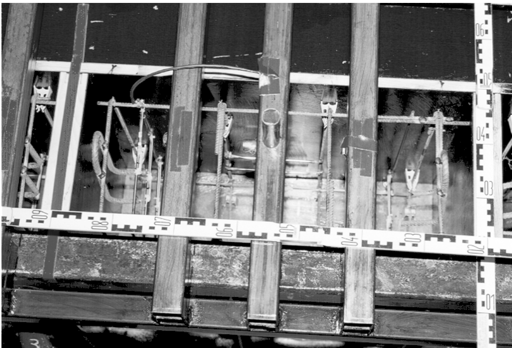
Abbildung I 2 Balken VK1a vor Betonieren mit Aussparungskörper für Bohrloch
