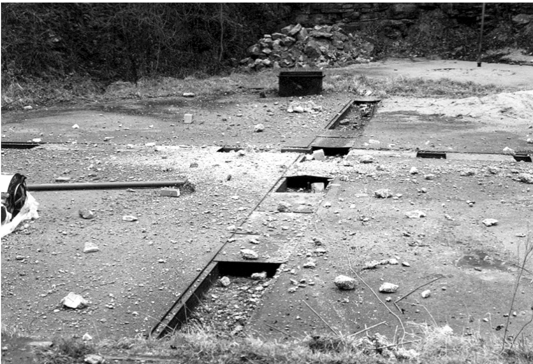
Abbildung 5-12 Sprengergebnis beim Versuch an Platte 2, totale Zerstörung
