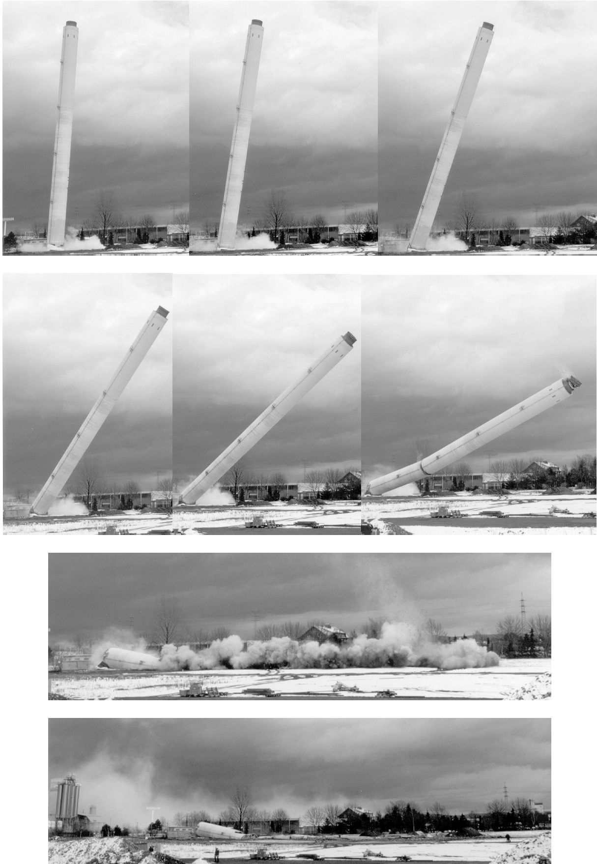
Abbildung 3-2 Fallbewegung des Schornsteins bei einer Kippsprengung
