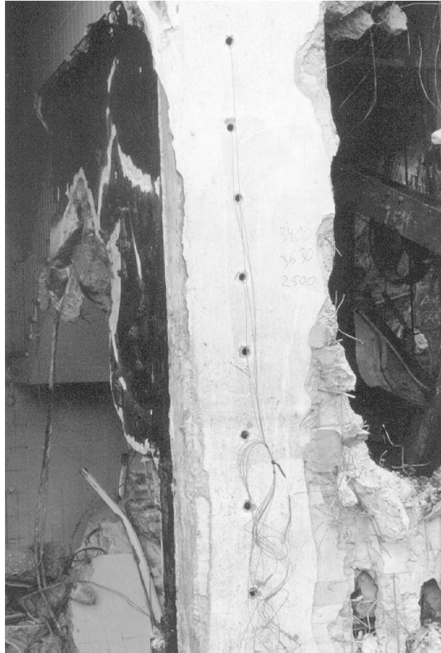
Abbildung 3-7 Beladene Bohrlöcher in Stütze mit angeschlossener Zündleitung
