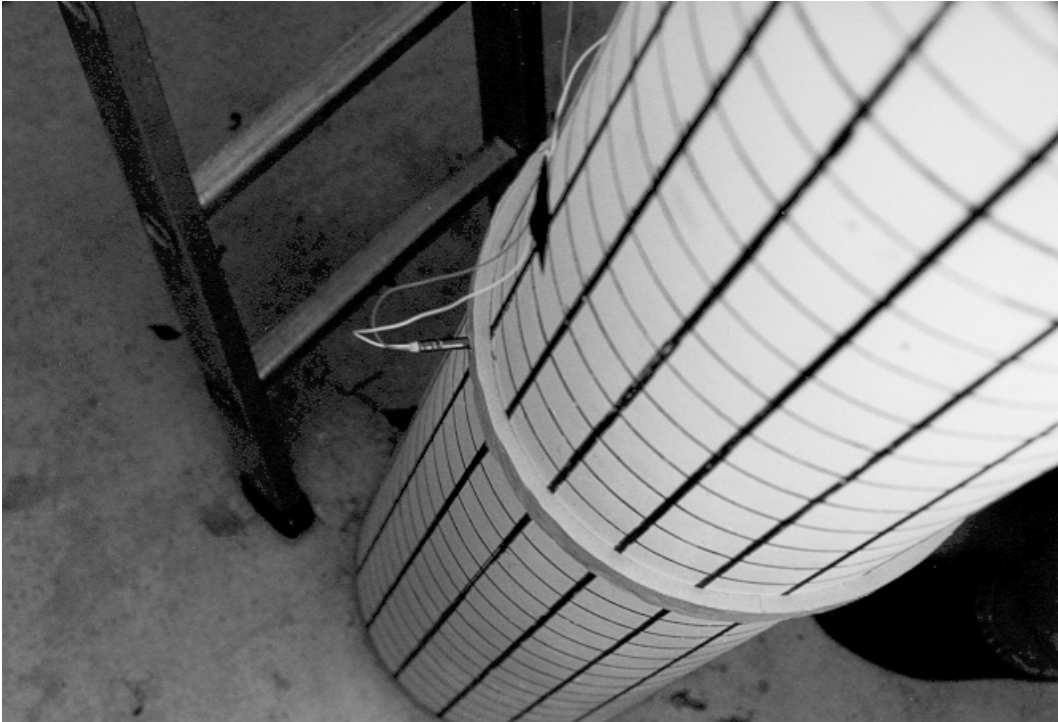
Abbildung K 7 Stütze vor Sprengung mit angebrachter Ladung und Zünder
