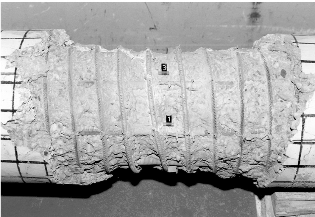
Abbildung K 12 Sprengergebnis, Bereich der Abplatzung
