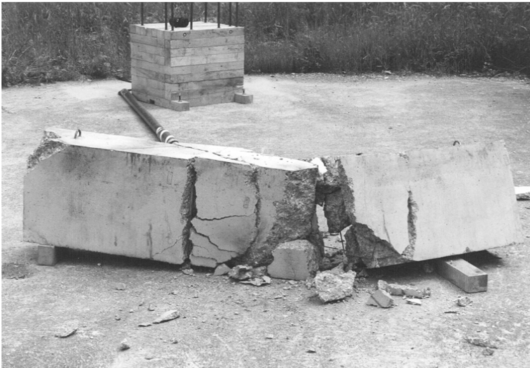
Abbildung 6-11 Sprengergebnis Balken VK2, Schädigung nach Detonation der zweiten Bohrlochladung (rechts)
