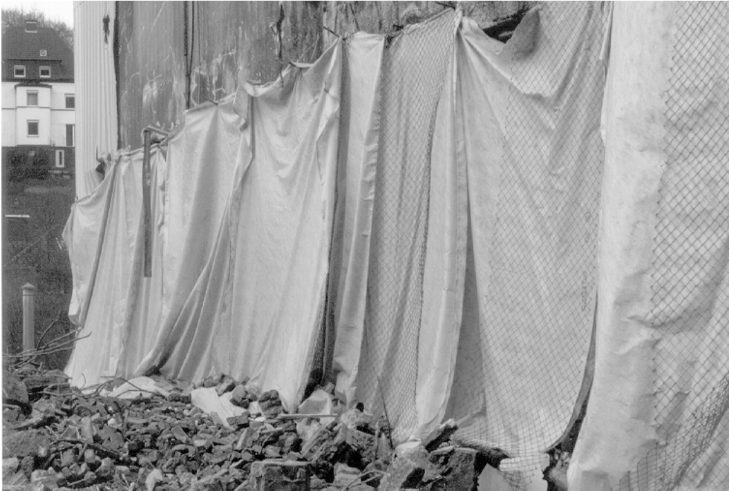
Abbildung 3-9 Abdeckerarbeiten im Sprengbereich mit Vlies und Maschendraht
