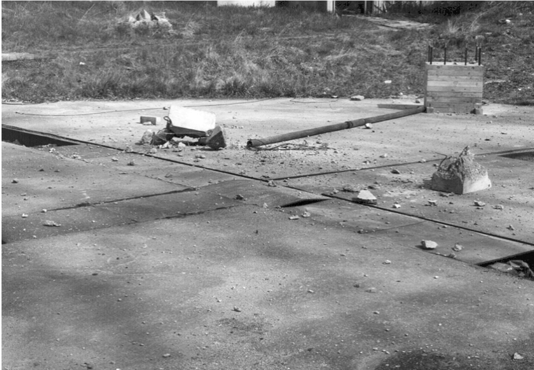
Abbildung I 5 Sprengergebnis Balken VK1a, totale Zerstörung
