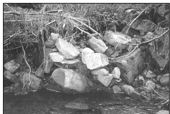
Abb. 52: Terrasse aus extrem blockreichem Substrat, GOK ca. 1,5 m über Mittelwasser
