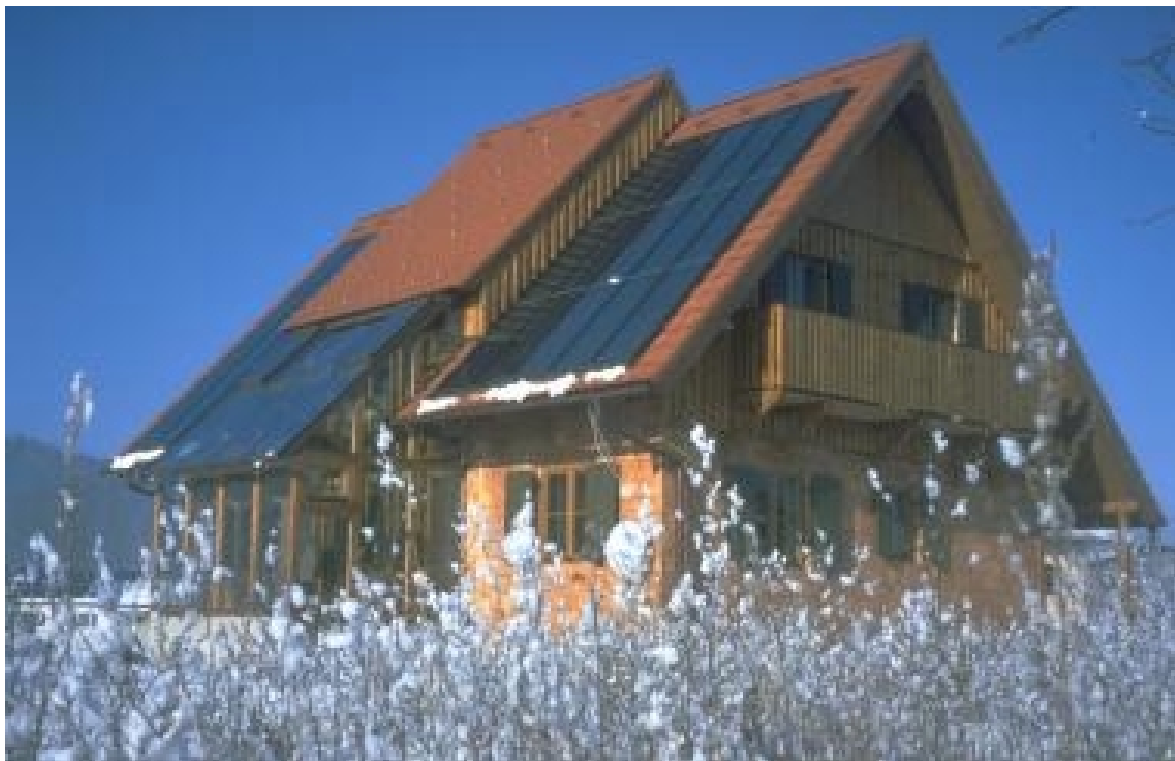
Abbildung 7.7.: Anlage zur solaren Heizungsunterstützung der Familie Bauer
