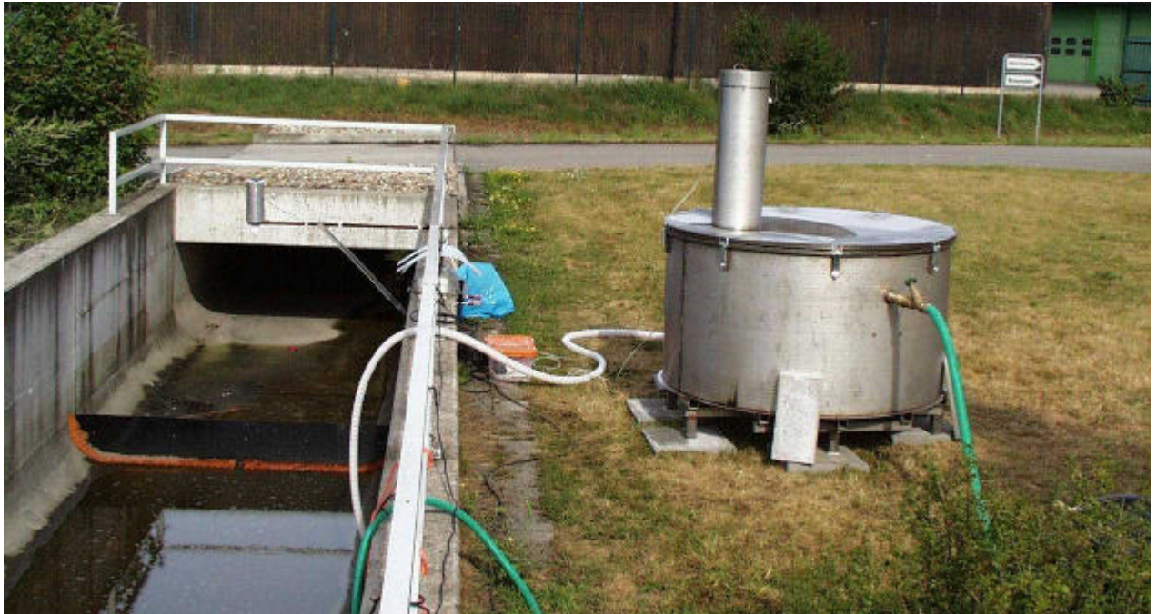
Bild 3-4: Der entwickelte Akkumulationsprobenehmer am Gerinne des Klärüberlaufs des RÜB auf der Kläranlage Bruchsal
