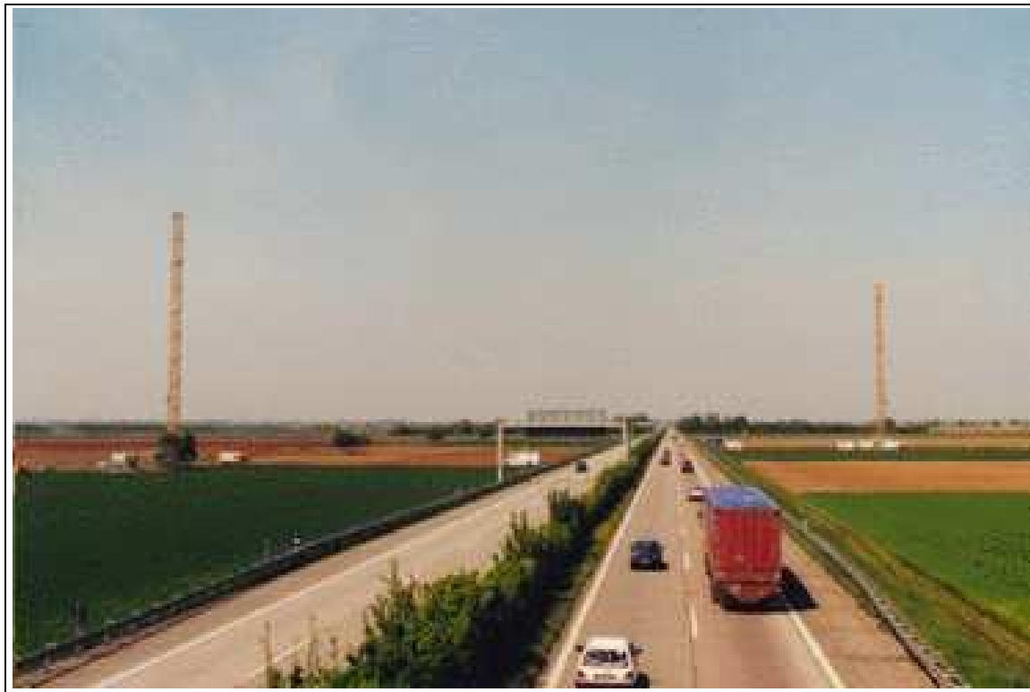
Abbildung 3.2: Photographie des BABII-Messfeldes mit den zwei Messtürmen links und rechts der Autobahn von einer nahe gelegenen Autobahnbrücke mit Blickrichtung Mannheim.
