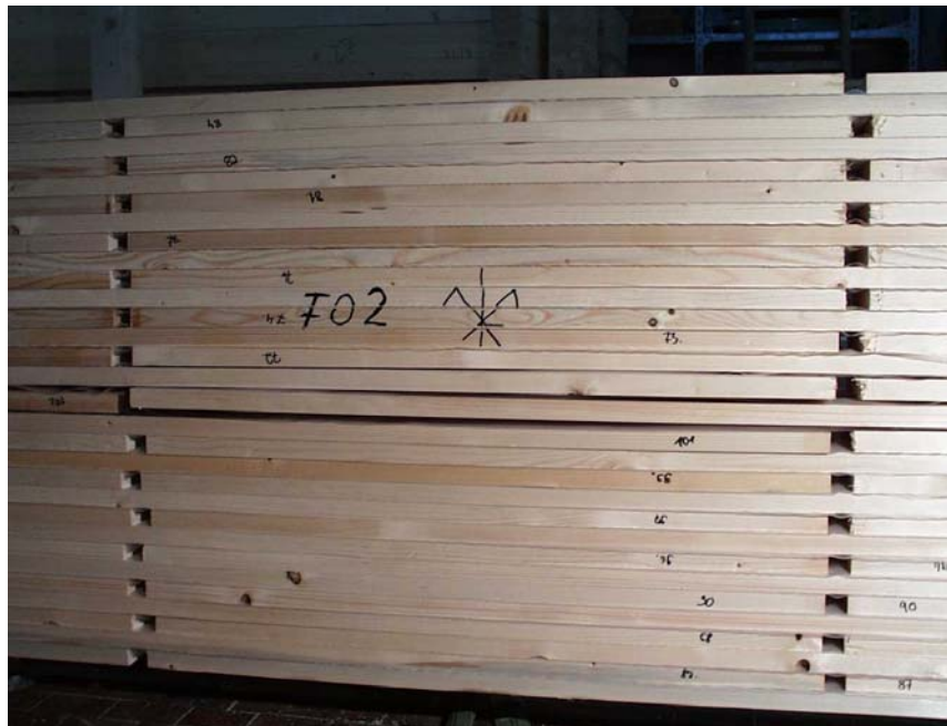
Bild 2- 1 Brettstapelelement mit regelmäßig gestoßenen Lamellen
