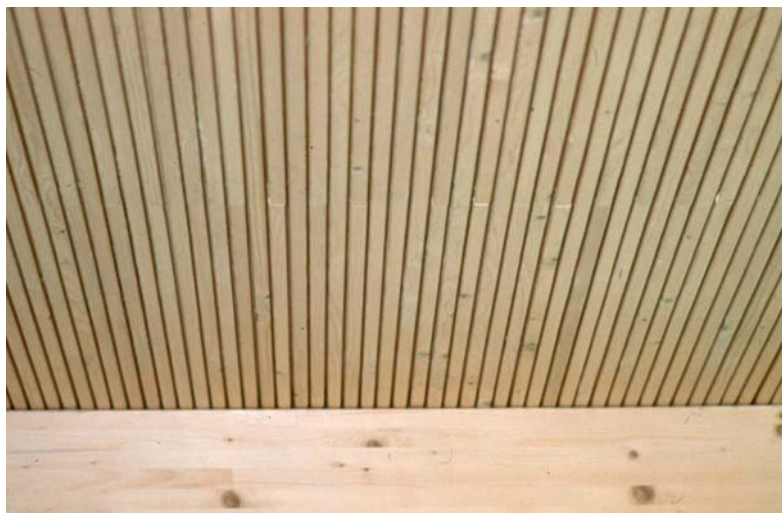
Bild 1- 1 Untersicht einer Brettstapeldecke mit Unterzug
