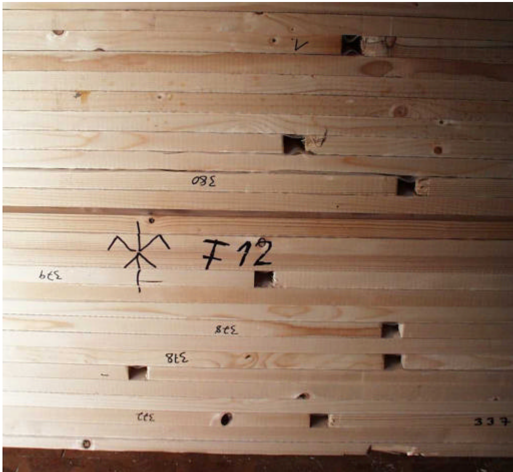
Bild D- 6 Zufällig verteilte Stöße im Brettstapelelement
