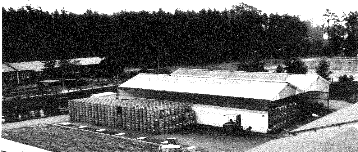
Abb. 13 Lager für feste schwachaktive Abfälle
