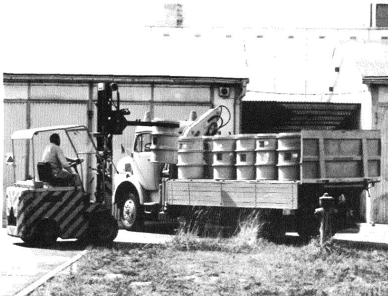
Abb. 3 Verladung fester schwachradioaktiver Abfälle
