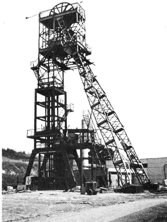
Abb. 1 : Ansicht des umgebauten und verstärkten Fördergerüsts kurz vor der Fertigstellung
