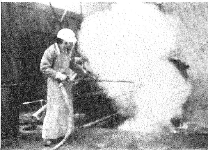
Abb. 27 Beseitigung der Brandrückstände mit Dampf
