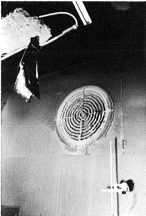
Abb. 17 Ablagerung von Aerosolen an der Einströmöffnung der Abluftanlage
