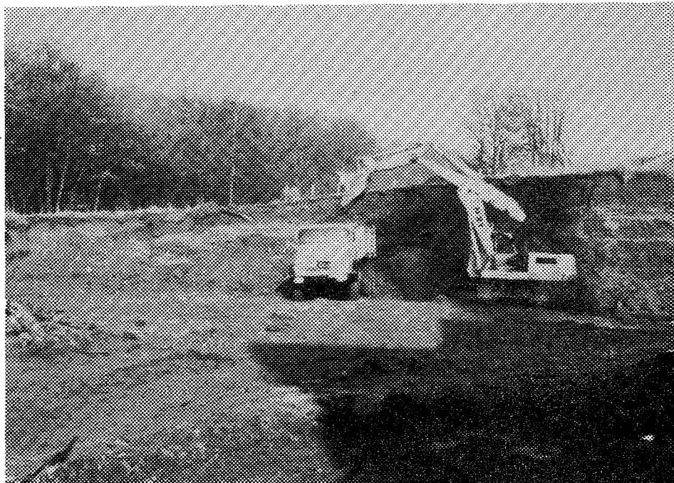
Abb. 9: Abtragung des Hanggeländes
