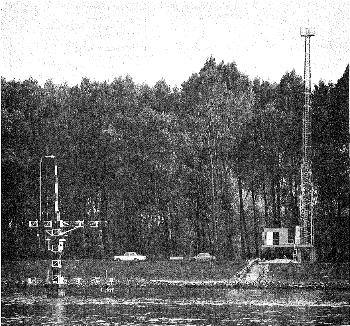
Abb. 4: Ansicht der gesamten Anlage
