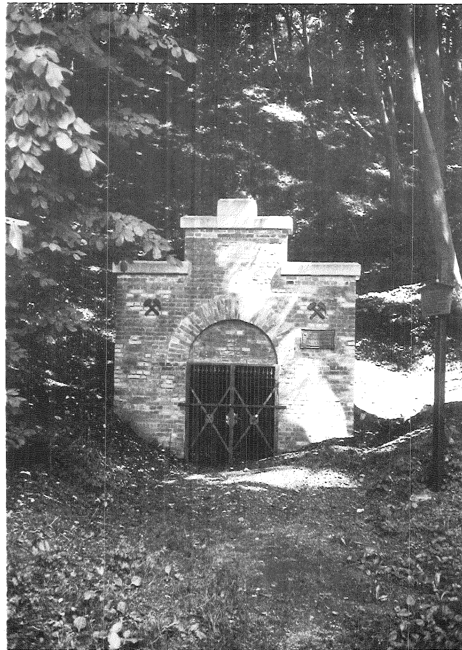
104 Tiefer Stollen / Wasseralfingen
