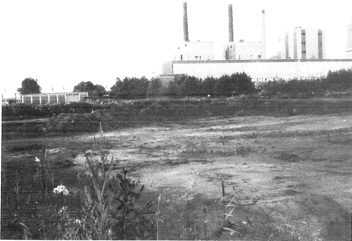
223: Ascheeinspülung, Zwischendeponie, Kraftwerk Emden
