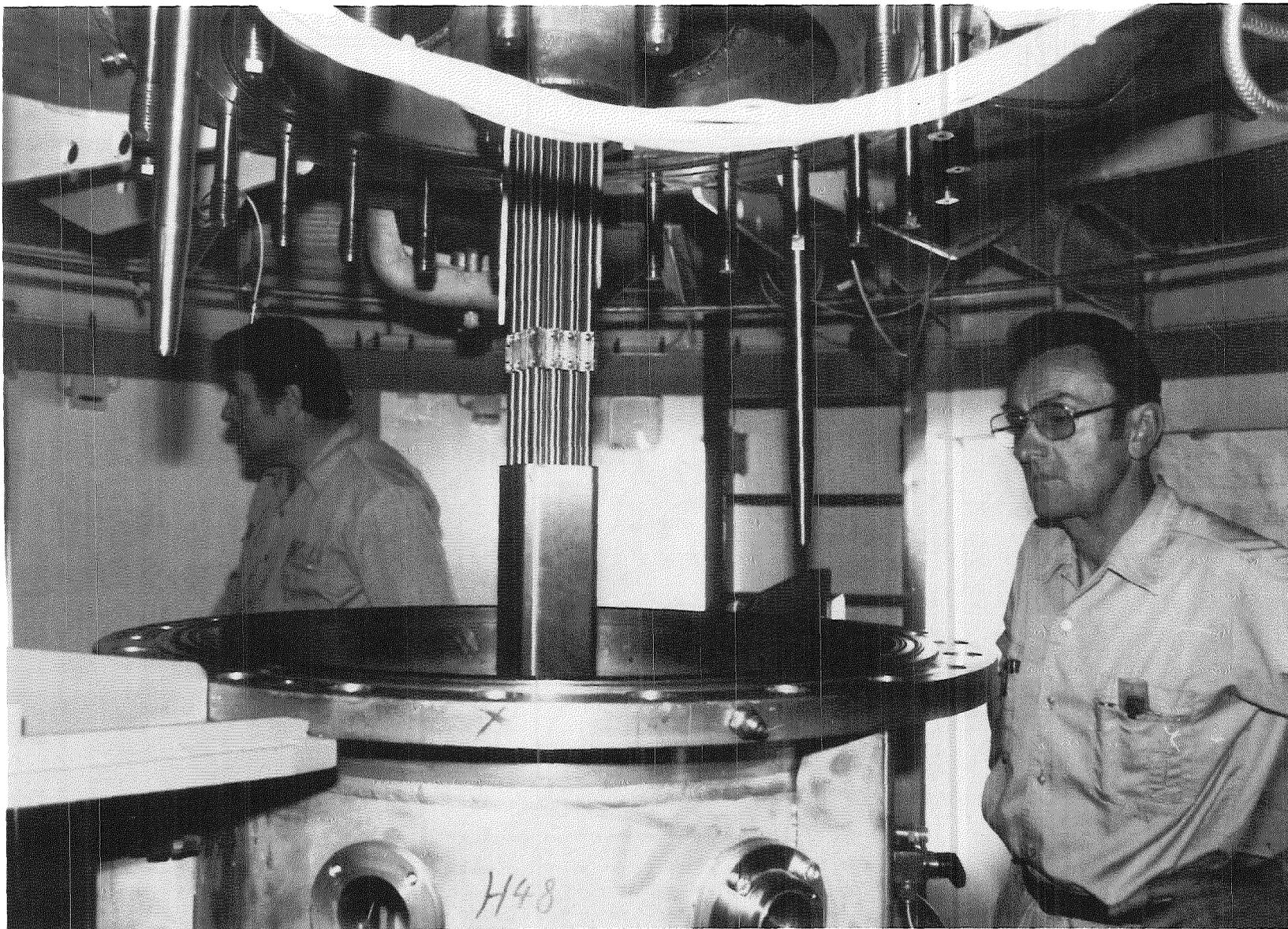
Fig. 17: PARTIALLY LOWERED HIGH TEMPERATURE SHIELD
