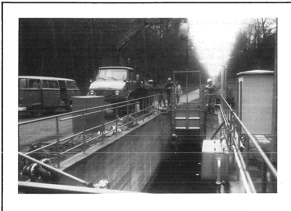
Abb. 2/13: Einbau eines Absperrschiebers am Sandfang VI
