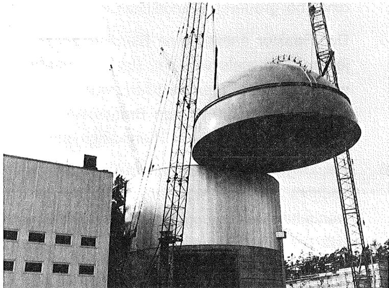
Die Kuppel des KNK-Sicherheitsbehälters wird aufgesetzt (1967)
