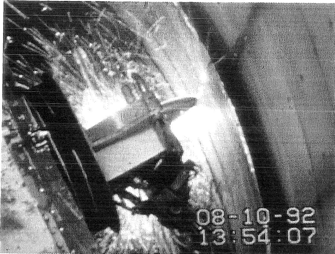
Abbildung 20: Blick von der Drehmanipulorkamera aus auf die Ringsäge während der Zersägung der Moderator tankwand (Monitoraufnahme). Rechts daneben der den Moderator tank umgebende Thermische Schild.
