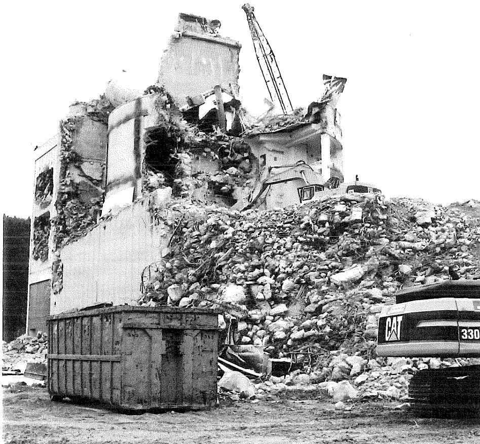
Abbildung 45: Konventioneller Abbruch der Gebäude. Blick über das abgebrochene ehemalige Maschinenhaus hinweg auf das zum Teil abgebrochene Reaktorgebäude mit Sicherheitsbehälter (Februar 1995).
