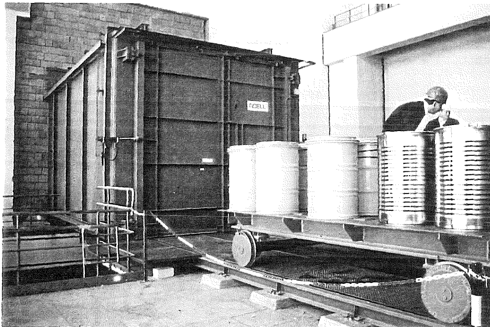
Abbildung 2: Blick auf die neue Materialschleuse mit Schleusenwagen, Maschinenhaus Höhenkote +11,50 m.
