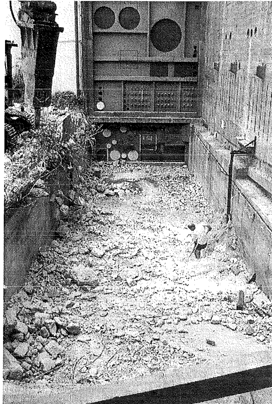
Abb. 25: Abriss des Rohrkanals
