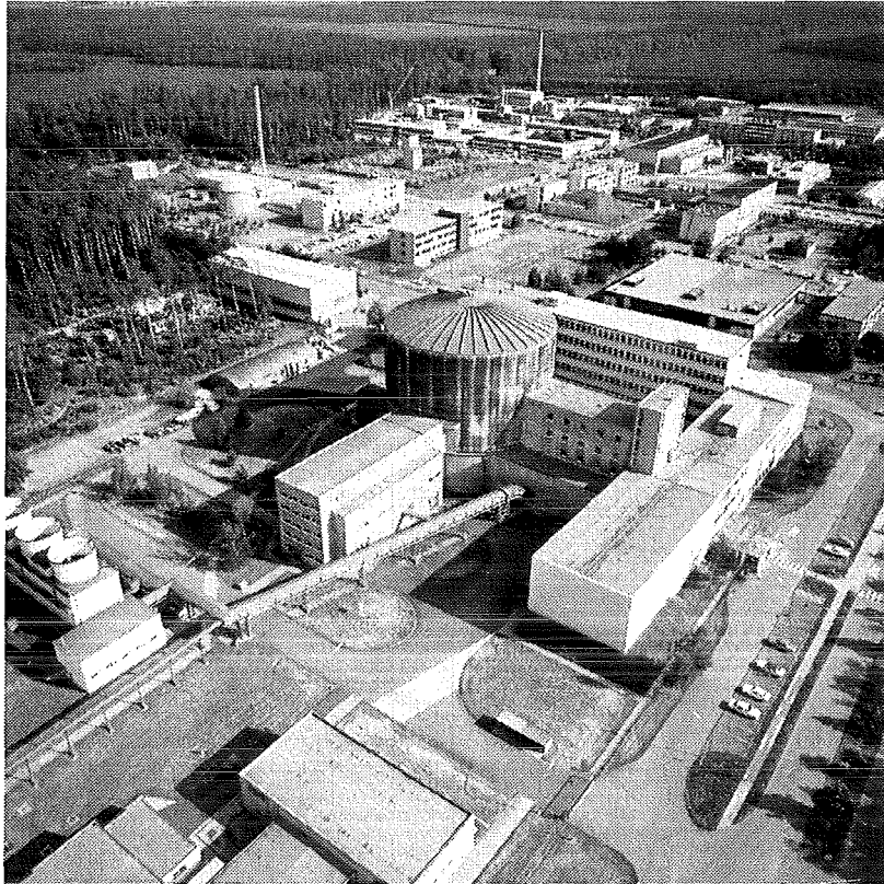
Abb. 1: Gesamtanlage FR 2 zu Beginn der Stilligungsarbeiten (Frühjahr 1982)
