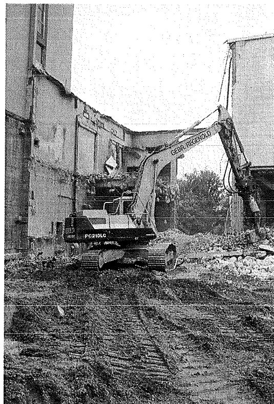
Abb. 26: Abriss des Lüftungsgebäudes
