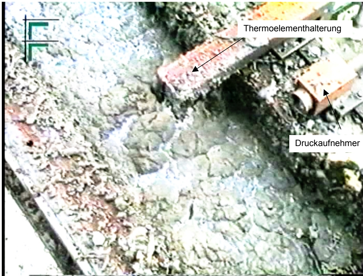
Abb. 4.8: Unzerklüftete Oberflächenstruktur im zweiten, gefluteten Bereich
