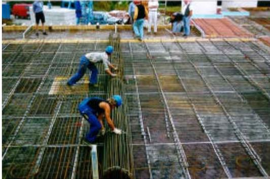
Abb. 3.18: Ausrollen der Bewehrungsmatten (Quelle: Fa. BAMTEC-Süd)
