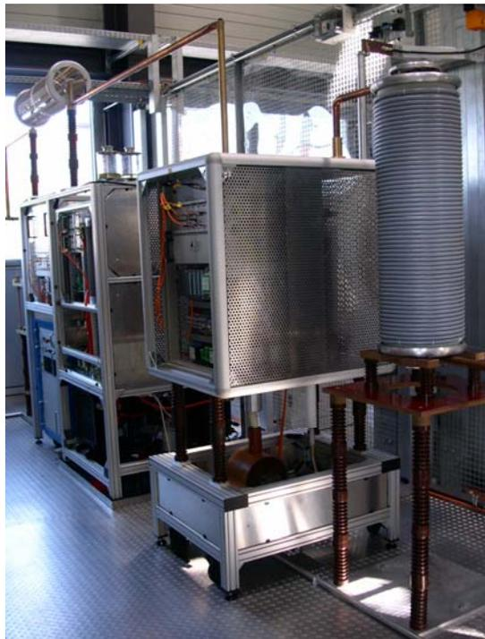
Hochspannungsmodulator, Thyatron-Crowbar mit Kathoden-Heizmodul und Zündspule für das Thyatron installiert im IPP Greifswald.
