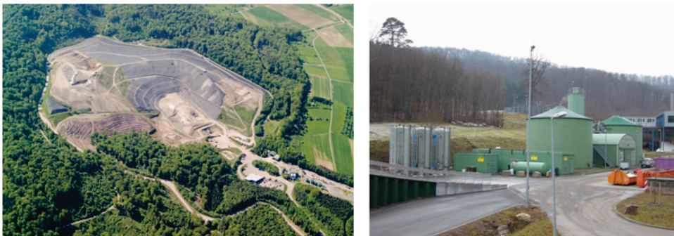
Abbildung 2: Die Deponie „Burghof“ (Landkreis Ludwigsburg) mit Sickerwasservorbehandlungsanlage (rechts)
