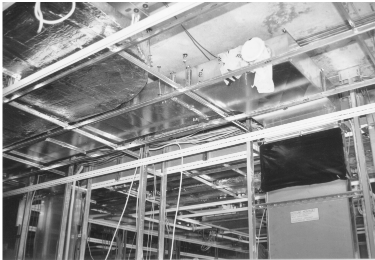
Bild 2.2 Grundkonstruktion der Decke und Wand mit Lüftungsschacht
