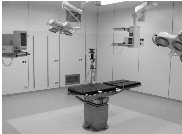
Bild 2.6 OP-Saal mit CrNi-Stahl-Verkleidung der Wände
