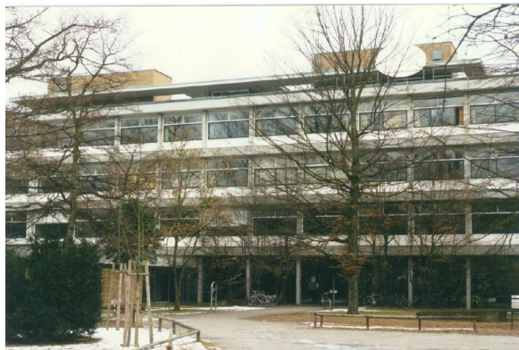
Bild A.1: Bürogebäude des Instituts für Höchstfrequenztechnik und Elektronik (IHE) der Universität Karlsruhe (TH)
