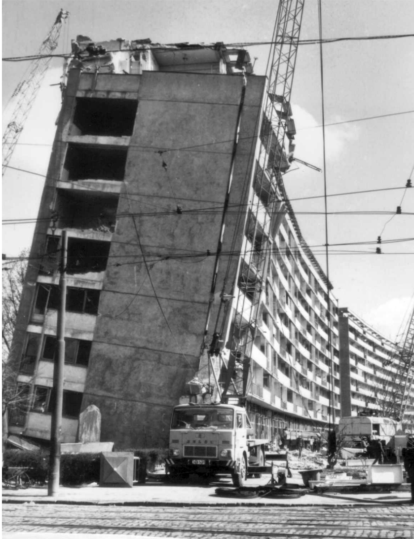
Abb. 4-8: Um 15° gekipptes Gebäude an der Sos. Stefan cel Mare. Der Grund für das Versagen waren zu schwach dimensionierte Stützpfeiler im Erdgeschoß, die infolge der Erdbebenlast zum Teil brachen (SANDI & VASILE, 1982; Aufnahme zur Verfügung gestellt von D. Lungu).
