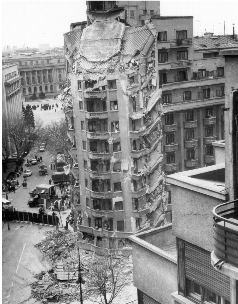
Abb. 4-9: Ein kollabiertes Erdgeschoß führte zum Absacken eines Gebäudeteils des „Wilson“-Wohnblocks im Stadtzentrum am Bd. Nicolae Balcescu. Der Vertikalversatz ist deutlich anhand der schräg hängenden Balkone sichtbar (SANDI & VASILE, 1982; Aufnahme zur Verfügung gestellt von D. Lungu).
