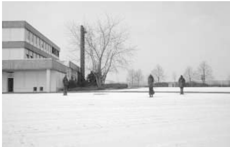
Abb. 80: WV 1/81; eine Schneedecke verhüllt die Bodenplatten
