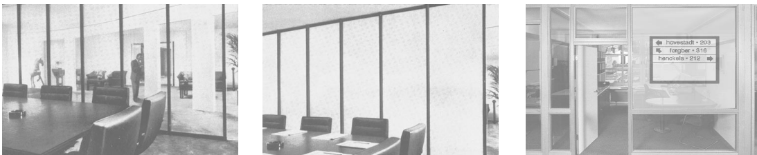
Abb. 4.16: Beispiel für eine Innenwand mit verschiedenen Funktionalitäten: transparent, opak und als Persönliches Leitsystem.
