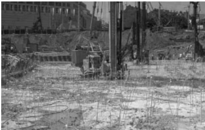
Abb. 5.8: Einrütteln der Injektionslanzen vor der Weichelinjektion (aus EISWIRTH, OHLENBUSCH & SCHNELL 1997)
